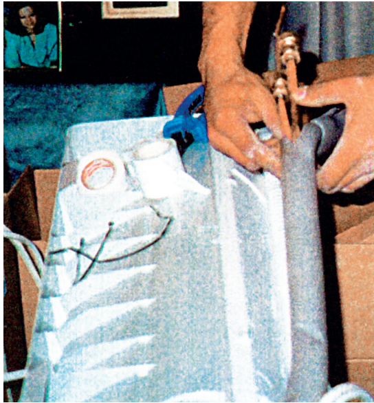
Εικόνα 6.4: Προετοιμασία σύνδεσης των αναμονών των χαλκοσωλήνων της εσωτερικής μονάδας.
