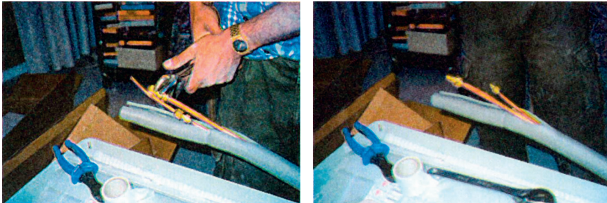
Εικόνα 6.5: Προετοιμασία σύνδεσης των αναμονών των χαλκοσωλήνων της εσωτερικής μονάδας.
