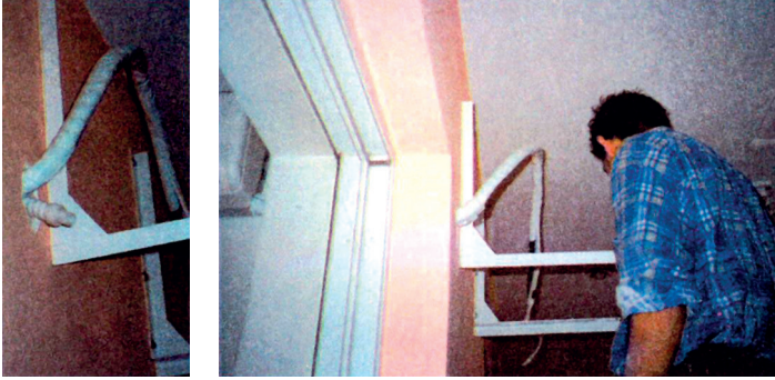
Εικόνα 7.1: Τοποθέτηση των μεταλλικών γωνιών στήριξης της εξωτερικής μονάδας πάνω στον εξωτερικό τοίχο.
