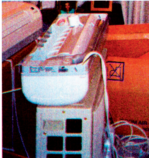
Εικόνα 6.3: Προετοιμασία των συνδέσεων της εσωτερικής μονάδας η οποία φαίνεται ανεστραμμένη. Παρατηρήστε τις αναμονές των χαλκοσωλήνων και των συνδέσεων των ηλεκτρικών καλωδίων, που έχουν γίνει στο άκρο της μονάδας.
