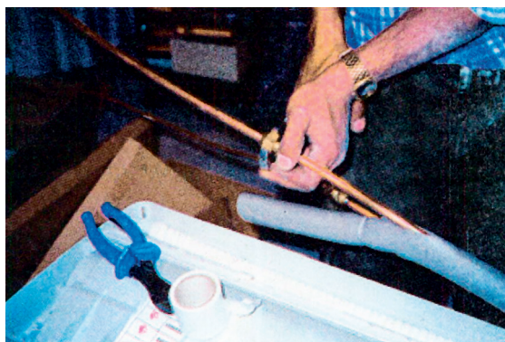
Εικόνα 6.7. Σύνδεση της επέκτασης των χαλκοσωλήνων στις αναμονές της εσωτερικής μονάδας.
