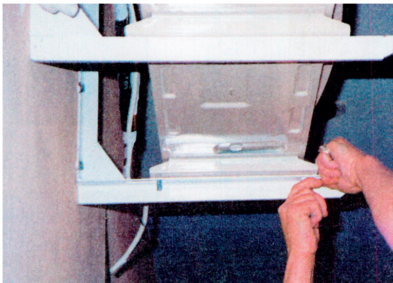
Εικόνα 7.3: Στερέωση της εξωτερικής μονάδας στη βάση στήριξης.
