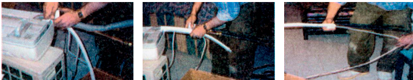
Εικόνα 6.10: Διαδικασία στερέωσης των σωλήνων και του ηλεκτρικού καλωδίου, τυλίγοντάς τα με μονωτική ταινία.
