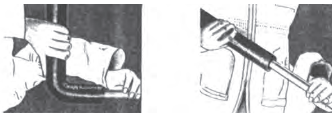
Σχήμα 4.5 Η μόνωση των σωλήνων ψυκτικού
