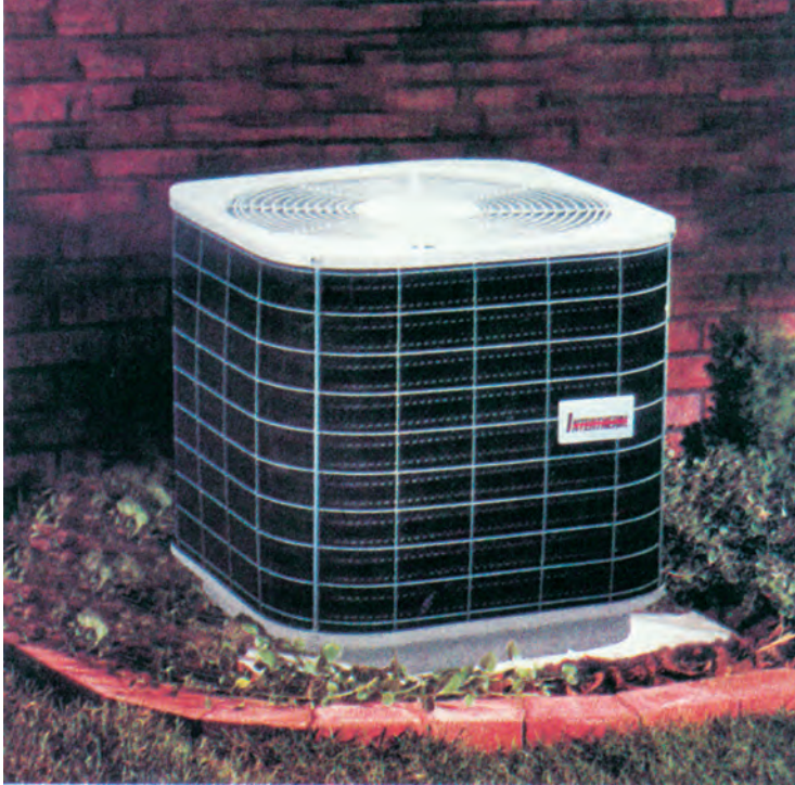
Σχήμα 3.1 Το εξωτερικό τμήμα κλιματιστικής μονάδας διαιρούμενου τύπου με κατακόρυφη ροή του αέρα (από κάτω προς τα άνω).
